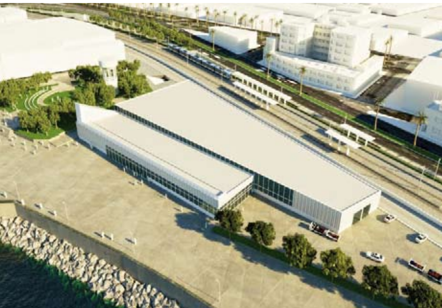
Nuevo Terminal de Pasajeros de Valparaíso (Imagen referencial).
