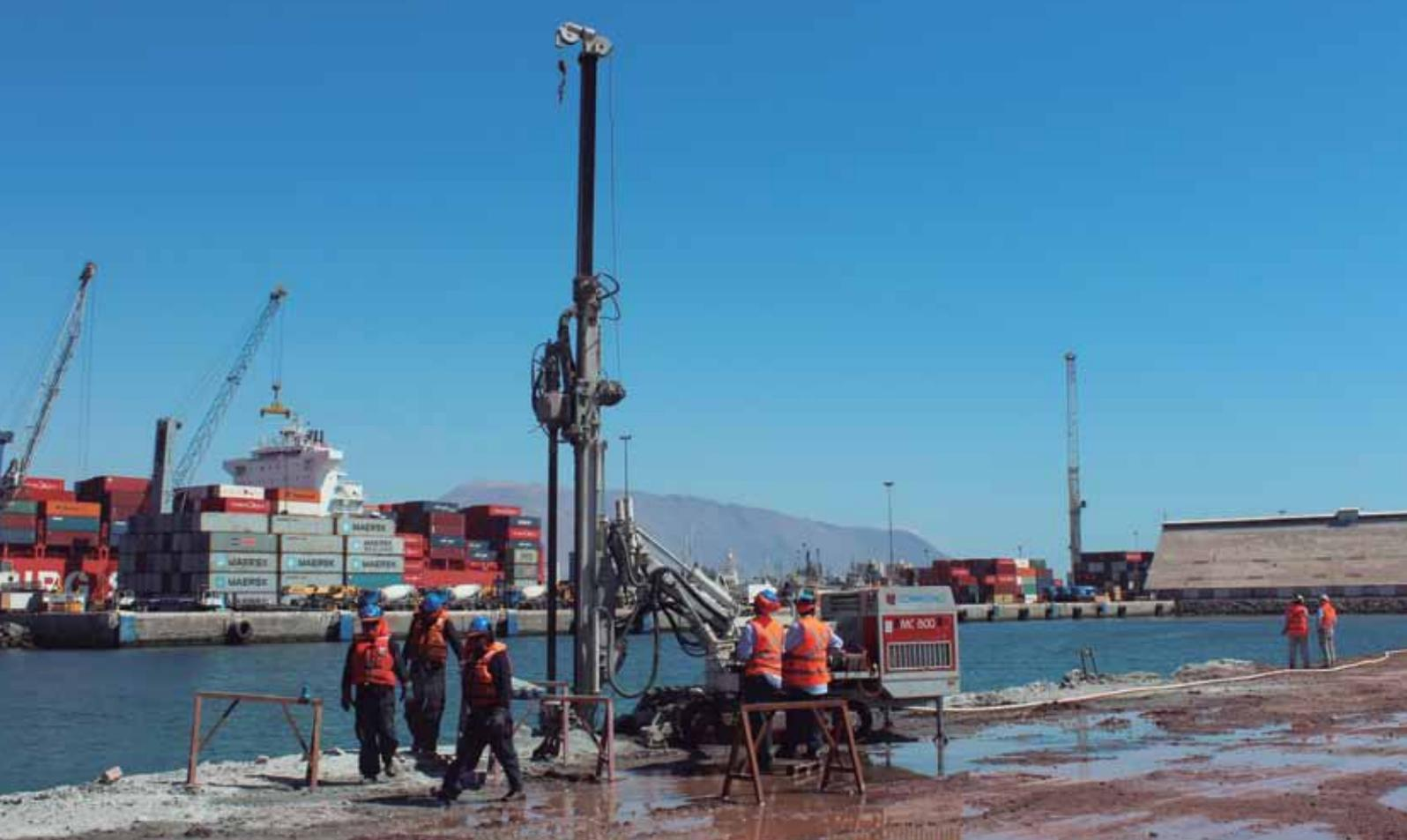
Perforaciones en Terminal N°1 del puerto de Iquique, donde serán instalados los micropilotes que actuarán como barras de estabilización del muelle.
