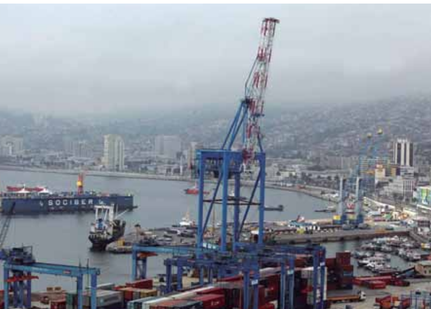
Valparaíso le dio la bienvenida a la segunda de las 3 grúas Ship to Shore (STS) que tendrá TPS.
