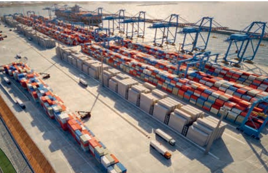
El proyecto tendrá capacidad para la atención de carga general de 2,25 millones de TEUs.
