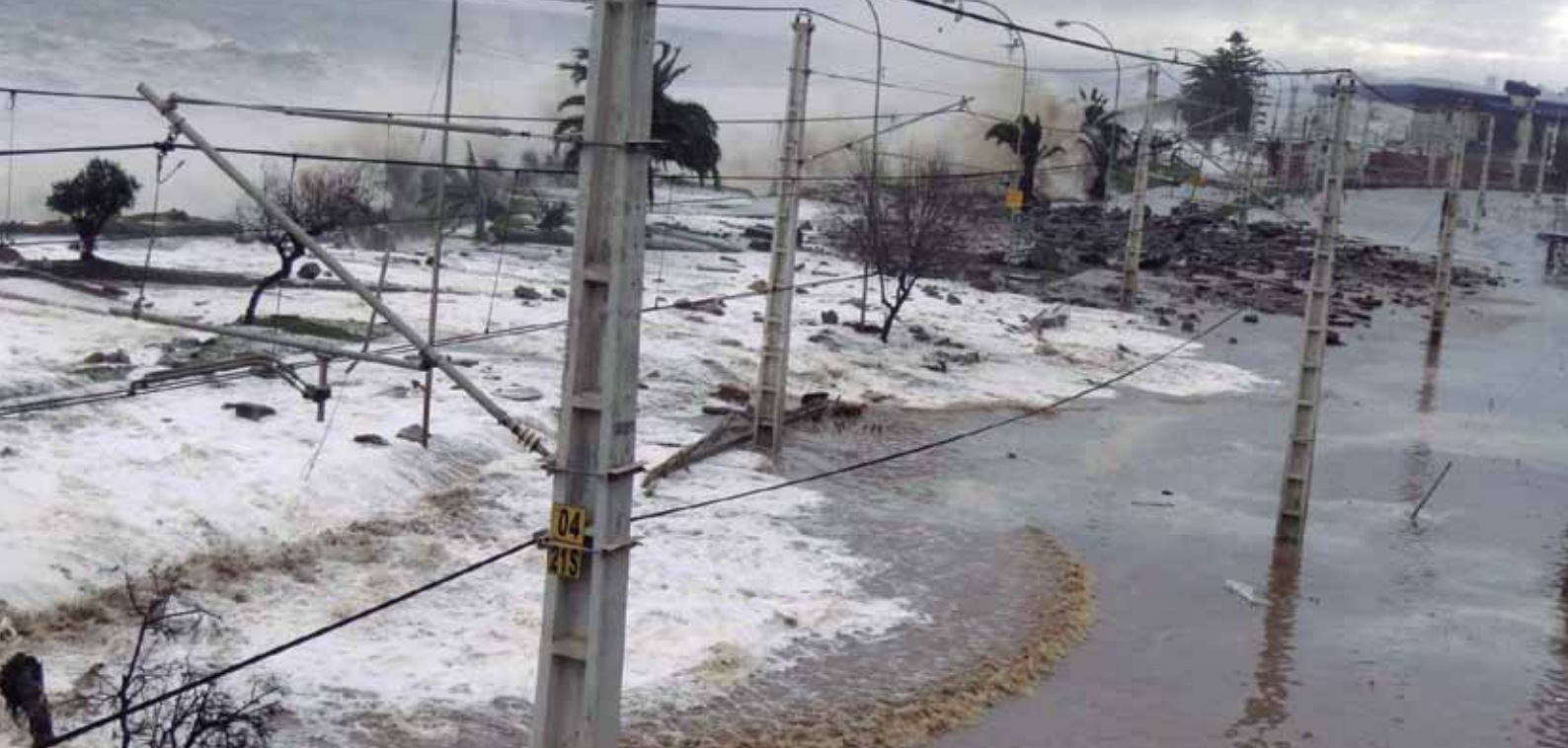
Efecto de las durante marejadas de agosto 2015 en Vías de Metro Valparaíso.
